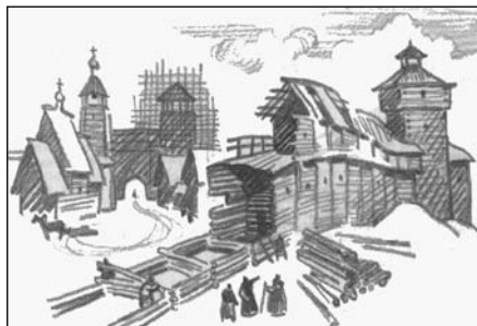
Строительство стен древнерусского города
