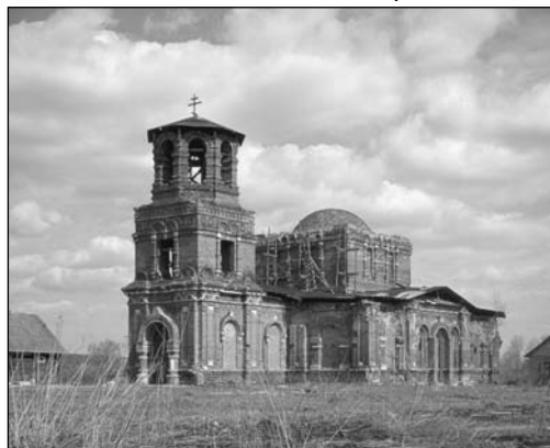
Церковь Вознесения в с.Бол.Руново до начала реставрации
