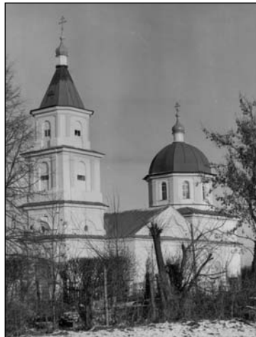
Церковь Преображения после ремонта в 1986 году
